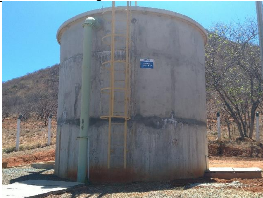
Figura 25 – Reservatório apoiado de distribuição do sistema de abastecimento de água de Matina
