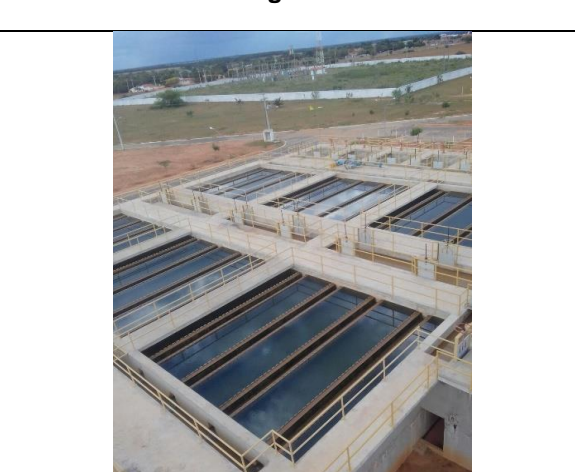
Figura 11 – Unidades de Decantação da ETA do Algodão
